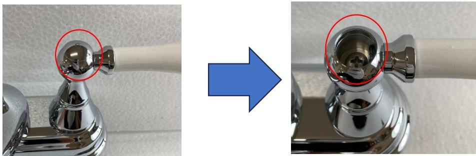
4、プラスドライバーを使い、反時計回りに回し、ハンドルを取り外す
