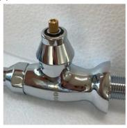
5、赤丸部材を半時計回りに回し、取り外し、バルブ(反時計回りで外す)を交換をします。 水:反時計回り用のバルブ/湯:時計回り用のバルブ
