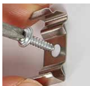
固定金具を取り付ける
